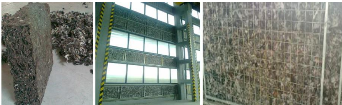
Obrázok 2. Detailný pohľad na obloženie zabezpečujúce odhlučnenie stavby (šrotoviska) z recyklovaných textílií [9]
